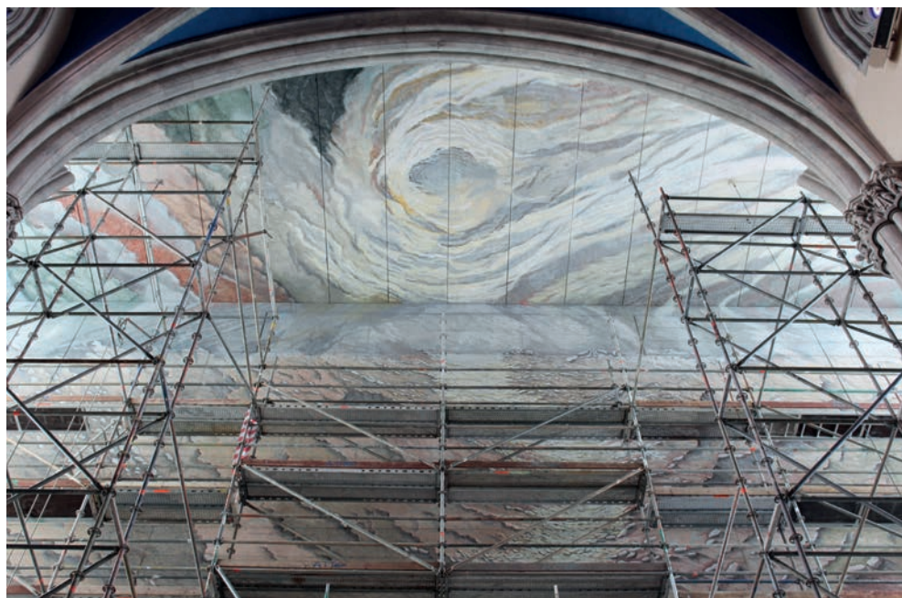
12. Obra en procés. Pigments i silicats sobre murs de formigó, església de Sant Joan Reus, 2016.
