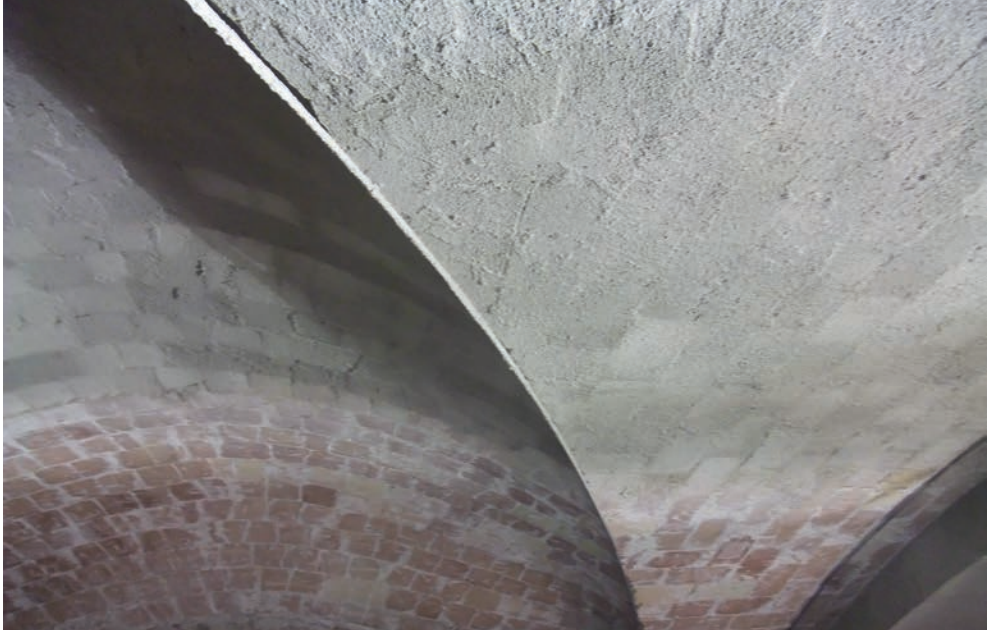
2. Emprimació d'una volta amb morter de calç projectat.
