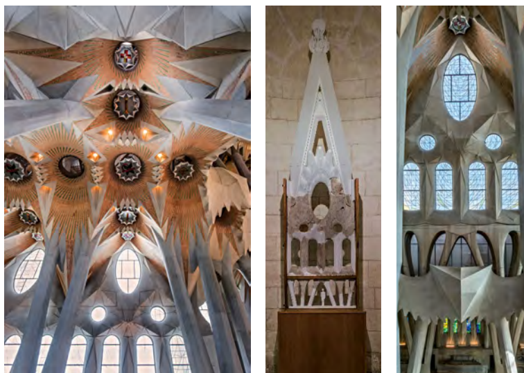
Hiperboloides de les lluernes de la volta de la nau central (esquerra). Finestral de la nau central: maqueta original a escala 1:10 i construït
