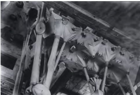
Maqueta original de les voltes de la nau lateral a escala 1:10. Geometria de l'hiperboloide.
