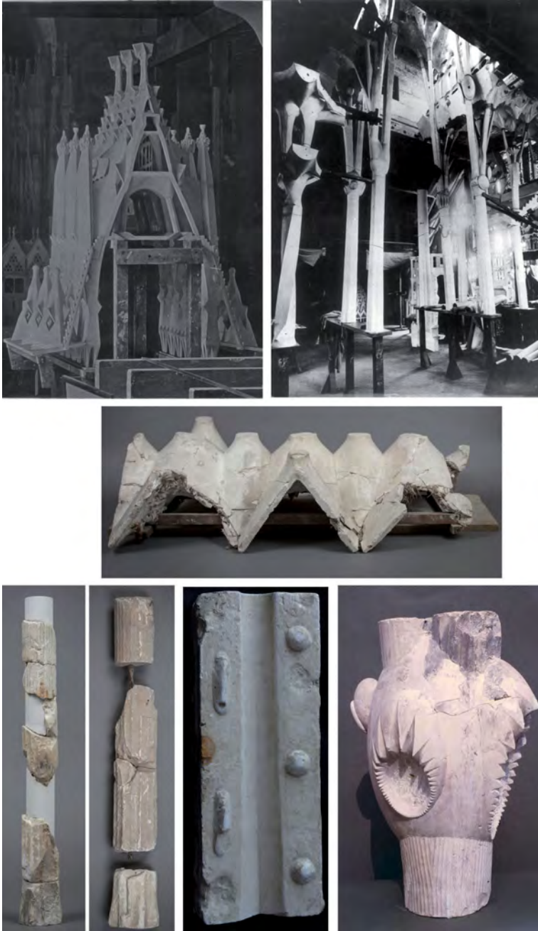
Alguns dels models i motlles originals d'Antoni Gaudí: cobertes de la nau, nau principal, voltes, columnes i nus de l'arbre de la nau central.
